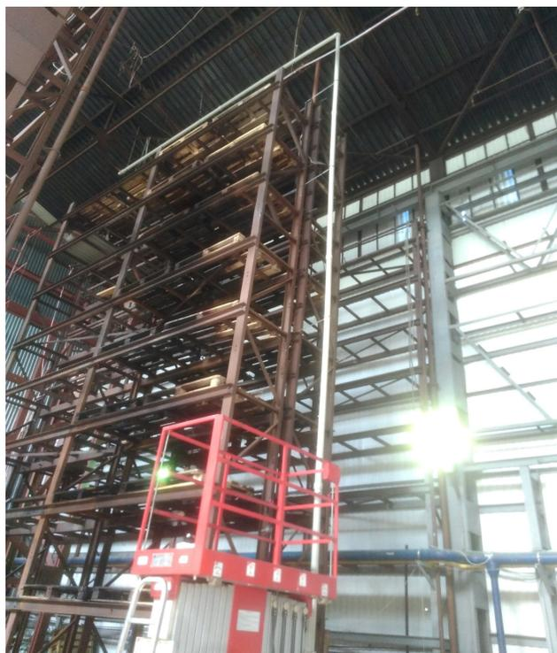
Монтаж трубопровода ПОТОК-FIREPROFF для испытаний.
